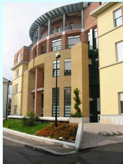
Nell'immagine sopra, l'ingresso al Presidio Ospedaliero di Arona.
